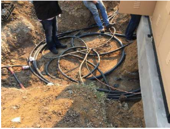
Installation of New Mini Sub-Station
