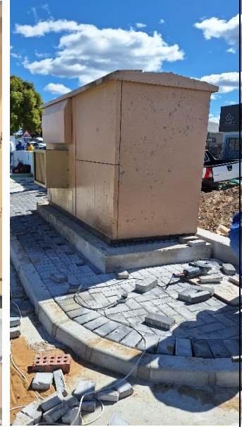
Mini Substation Installation
